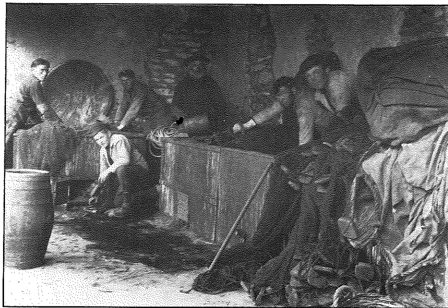
Marins au travail dans le hangar à tannée du nouvel Abri vers 1930. Au 1 er plan : tannée des filets de maquereaux et de voiles Au fond : tannée d'une "Poch'drague", CARROT (?) accroupi.
